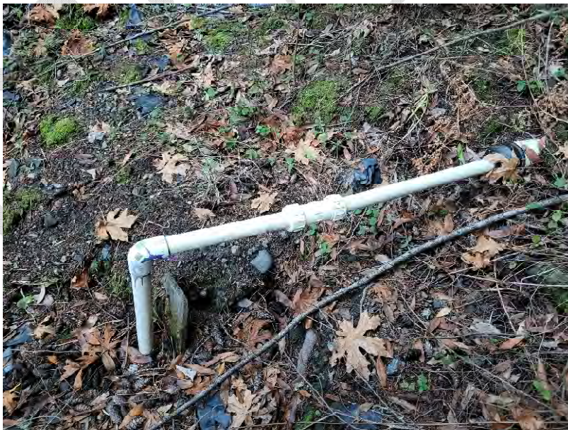
Photo 3: Bei Horizontal Well entry point
